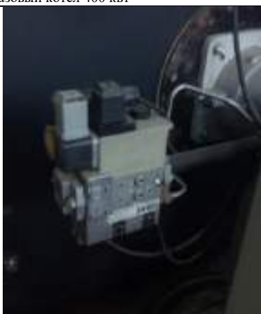
32 Дозатор топлива DUNGS MB-ZRDLE 407 B01S30, газовый котел 700 кВт
