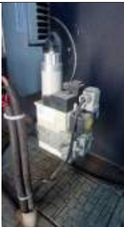
32 Дозатор топлива DUNGS MB-ZRDLE 407 B01S30, газовый котел 700 кВт
