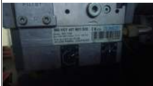
32 Дозатор топлива DUNGS MB-ZRDLE 407 B01S30, газовый котел 700 кВт
