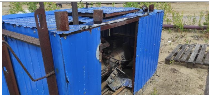
Электростанция ДГУ АД-12С-Т400-1РКМ 100 в кожухе 046
