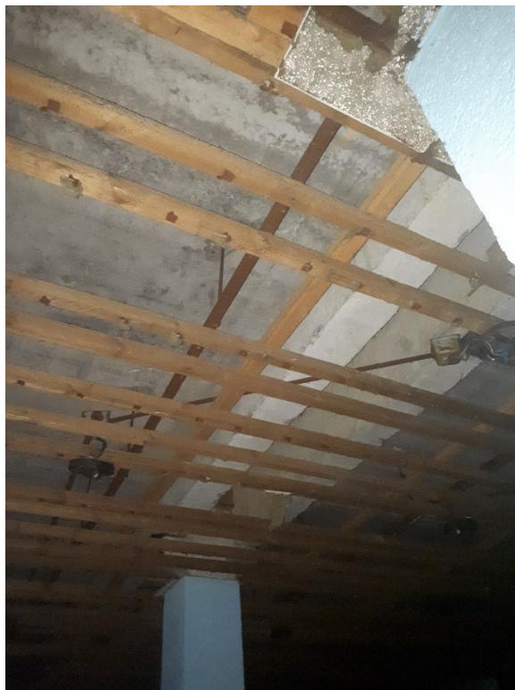
Фото №7. Общий вид конструкции перекрытия 1-го этажа в осях Б/1-2.
