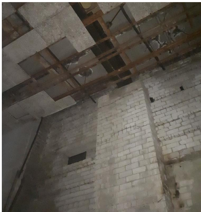
Фото №5. Фрагмент внутренней несущей стены в осях В/З (в уровне 2-го этажа).
