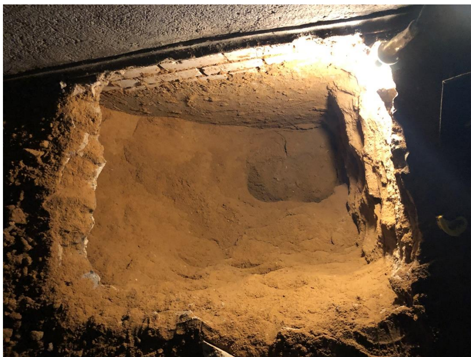
Фото №4. Шурф №3 в осях В-Г/5.
