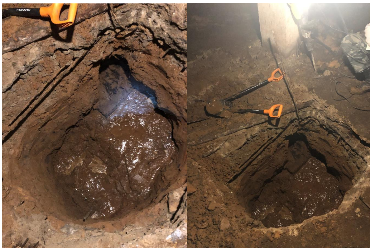
Фото №2. Шурф №1 в осях Б/2.
