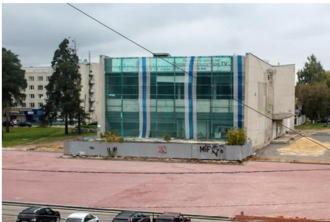
Фото №1. Общий вид фасада по оси Г.
