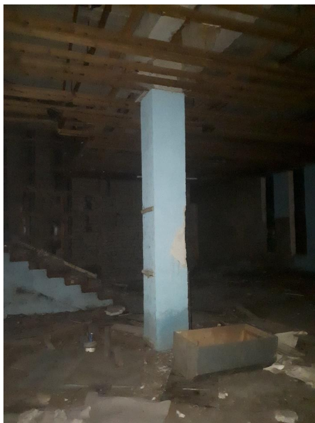
Фото №6. Колонна каркаса в осях Б/2 в уровне 1-го этажа.
