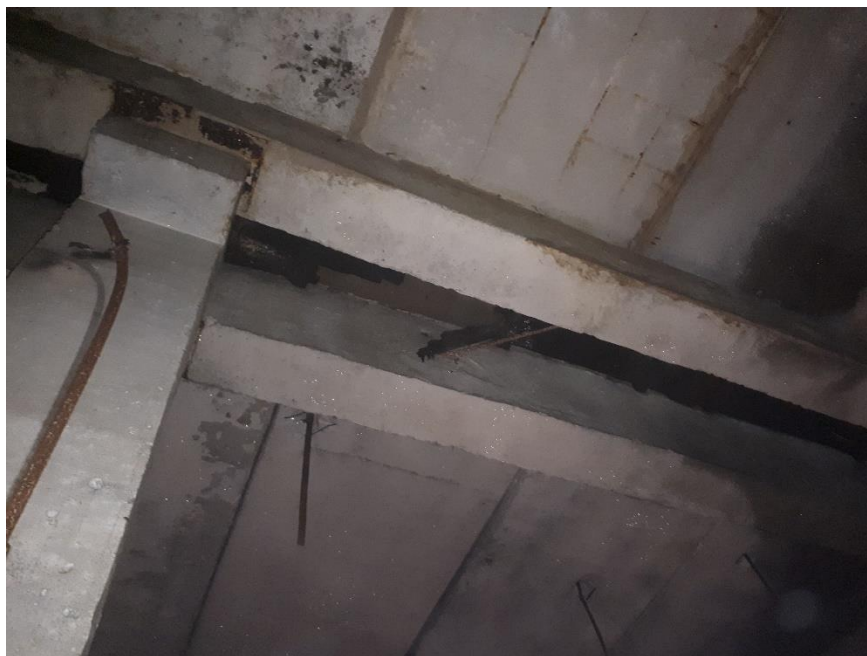
Фото №8. Общий вид конструкции перекрытия подвала в осях Б/1-2.
