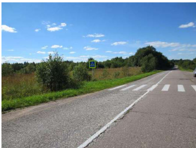
Фотография 15. Подъездные пути к участкам в Рядском сельском поселении
