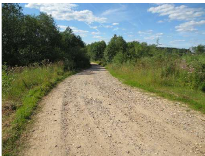
Фотография 7. Подъездные пути к участкам в Котлованском сельском поселении
