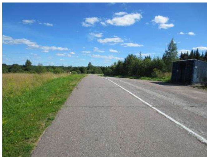
Фотография 14. Подъездные пути к участкам в Рядском сельском поселении
