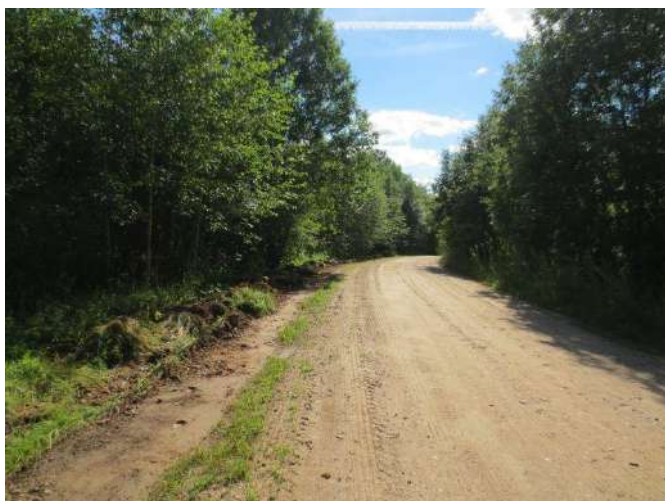
Фотография 9. Подъездные пути к участкам в Котлованском сельском поселении
