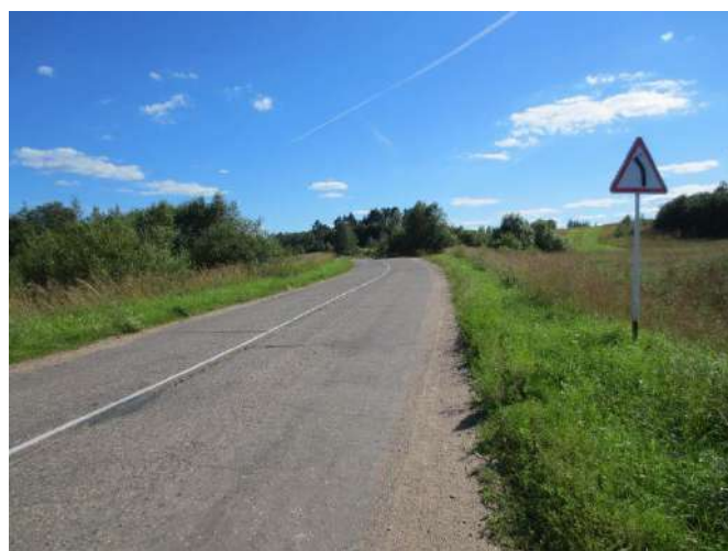
Фотография 18. Подъездные пути к участкам в Рядском сельском поселении
