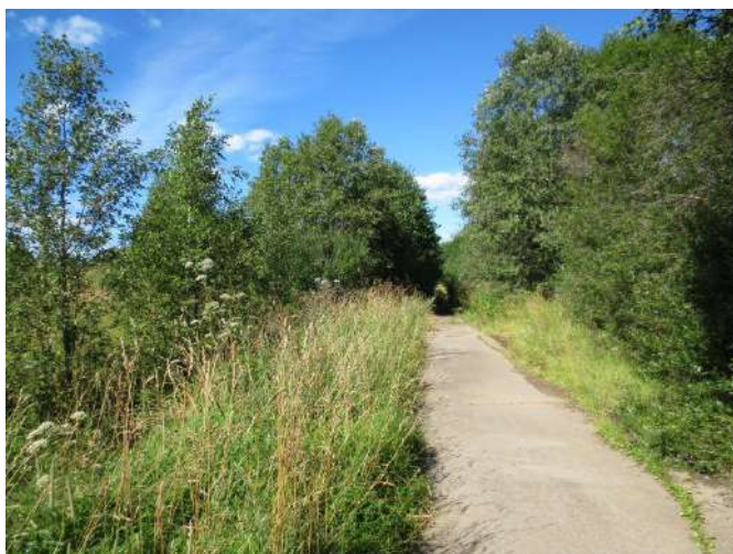
Фотография 13. Подъездные пути к участкам в Рядском сельском поселении
