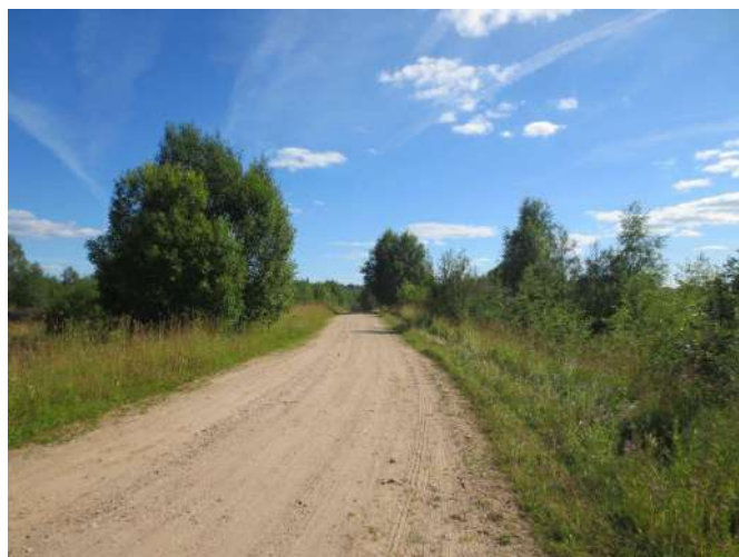
Фотография 12. Подъездные пути к участкам в Котлованском сельском поселении
