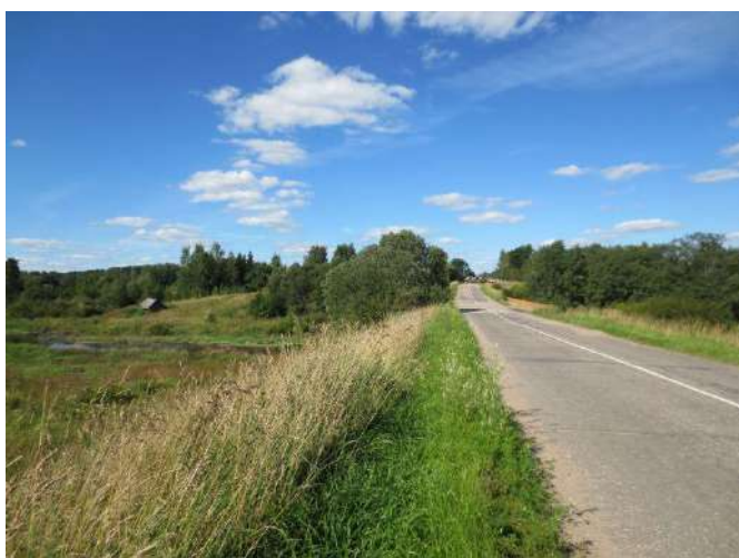
Фотография 17. Подъездные пути к участкам в Рядском сельском поселении
