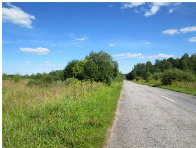
Фотография 16. Подъездные пути к участкам в Рядском сельском поселении
