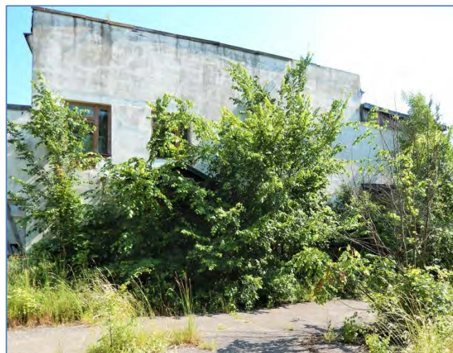
Левый торец здания столовой
