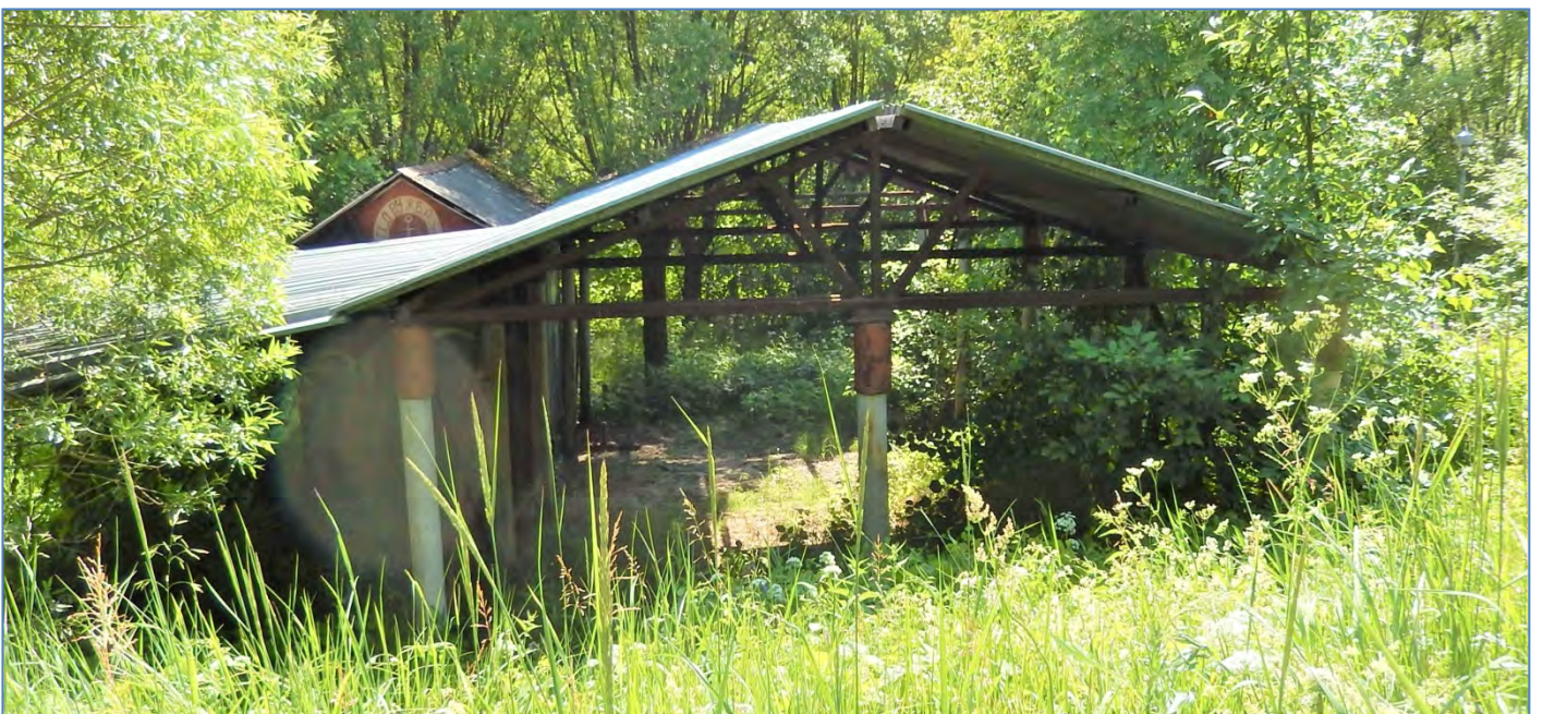
Эллинг (helling) — сооружение для хранения или ремонта малоразмерных плавсредств. Строились, как правило, из металла, дерева и других «лёгких» материалов...
