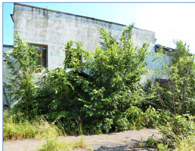
Левый торец здания столовой
