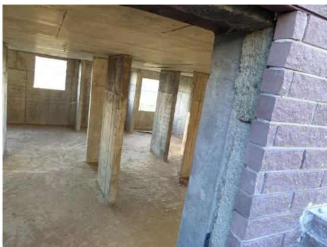
Фотография 63. Цокольный этаж дома 19
