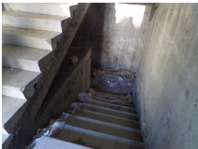
Фотография 45. Лестничная клетка
