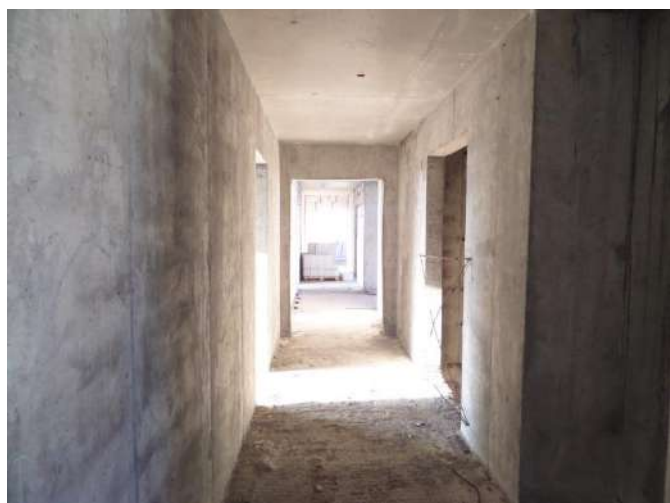
Фотография 46. Лестничная клетка
