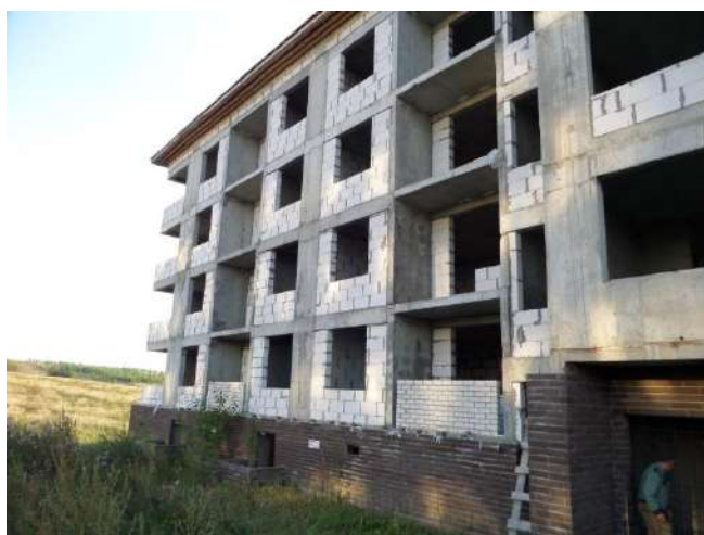
Фотография 43. Фасад строящегося дома 19
