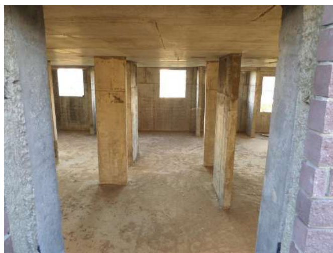
Фотография 62. Цокольный этаж дома 19
