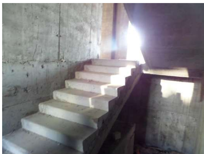
Фотография 44. Лестничная клетка
