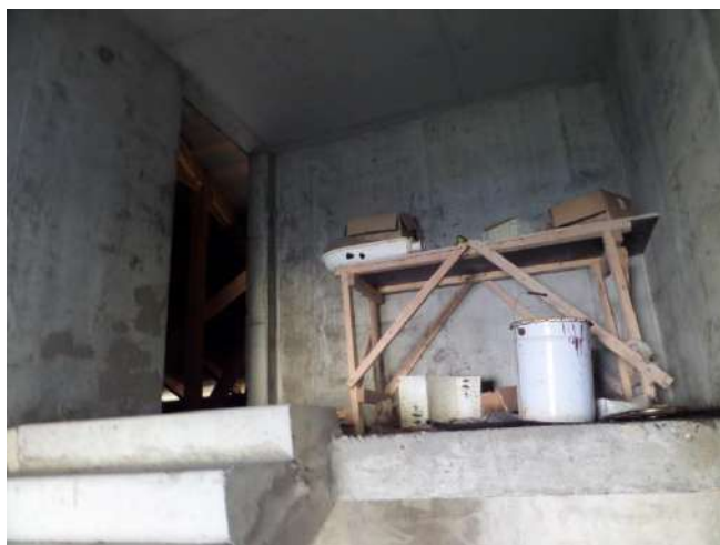
Фотография 47. Лестничная клетка
