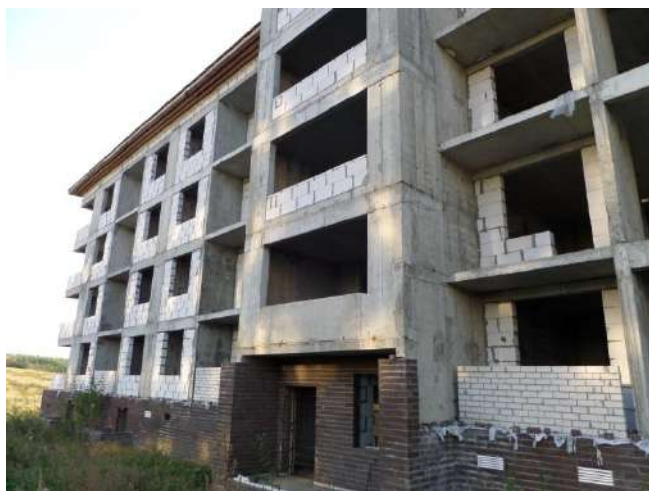
Фотография 41. Фасад строящегося дома 19
