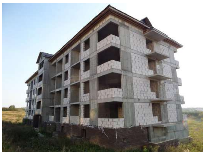
Фотография 38. Фасад строящегося дома 19
