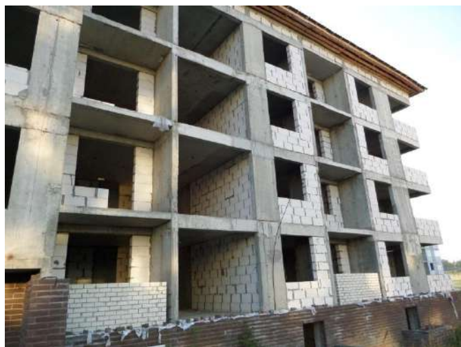
Фотография 42. Фасад строящегося дома 19
