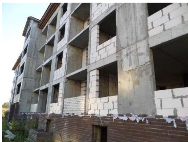
Фотография 39. Фасад строящегося дома 19
