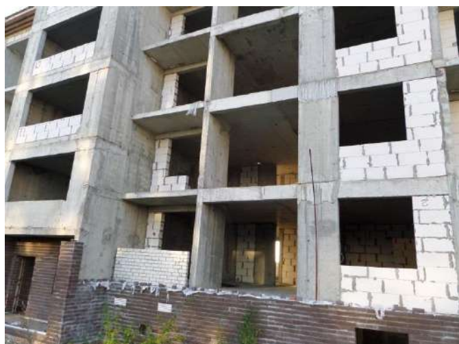
Фотография 40. Фасад строящегося дома 19
