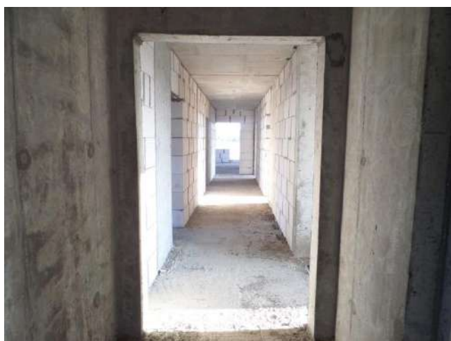
Фотография 49. Лестничная клетка
