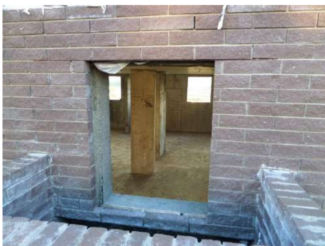
Фотография 61. Цокольный этаж дома 19
