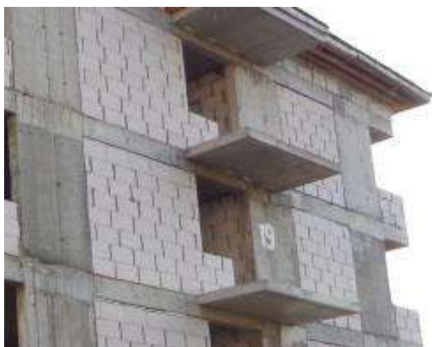
Фотография 37. Фасад строящегося дома 19
