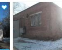
Производственное помещение, 127,3 м² 6 473 300 ₽ ● Козья Слобода, 2,5 км, 39-й квартал 3 недели назад
