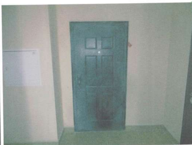
Входная дверь в квартиру № 68.
