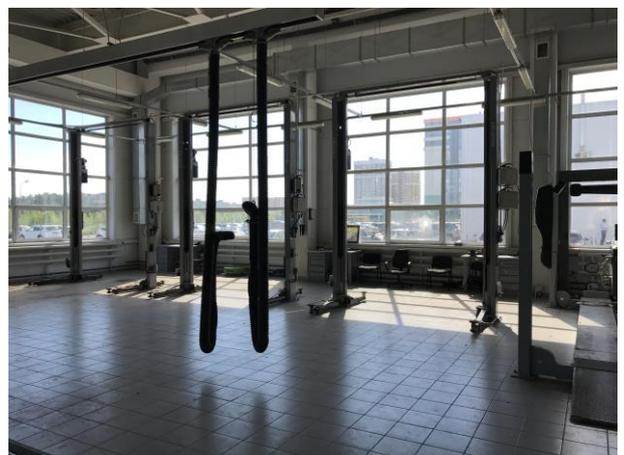
Фото 24. Подъемники и система удаления газов
