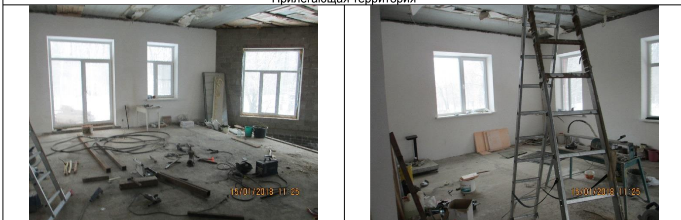
Состояние внутренних помещений
