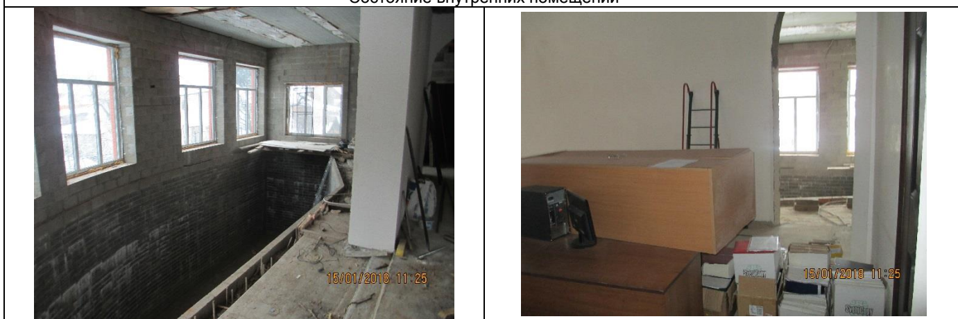
Состояние внутренних помещений
