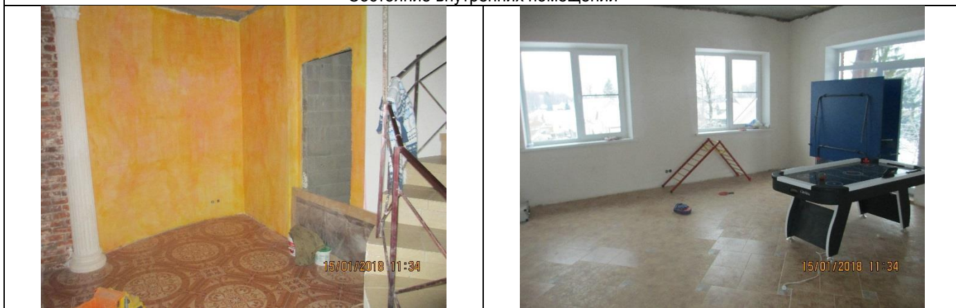
Состояние внутренних помещений
