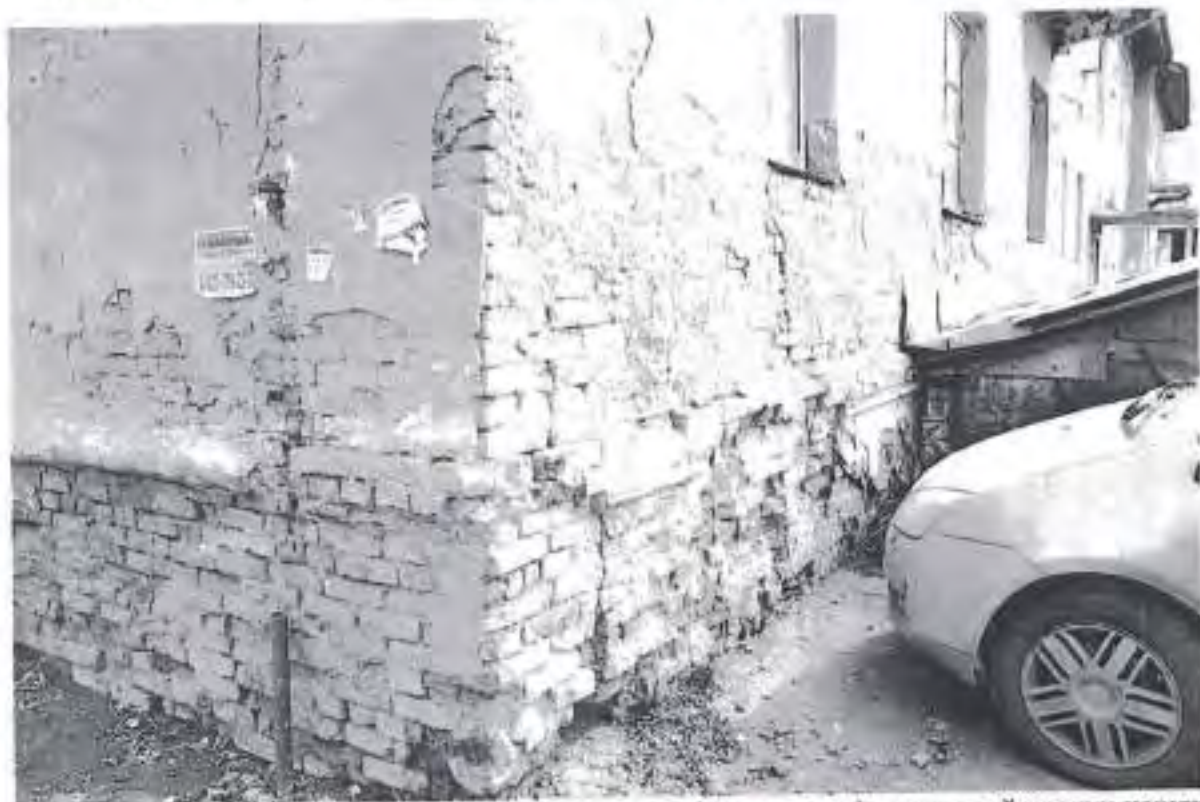
Фото 4. Разрушение наружной отделки. Деструкция (разрушение) кирпичной кладки наружных стен глубиной до 120 мм
